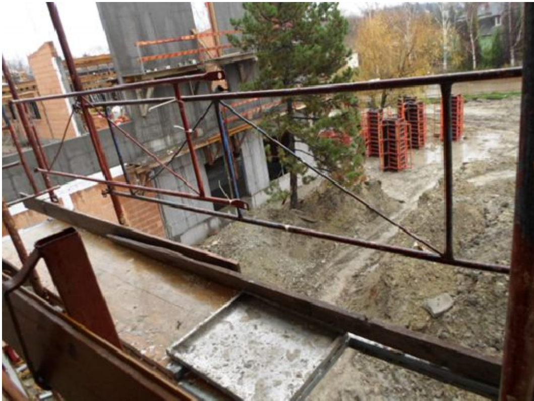
15. Korlátelem rögzítése gyorskötözővel.
