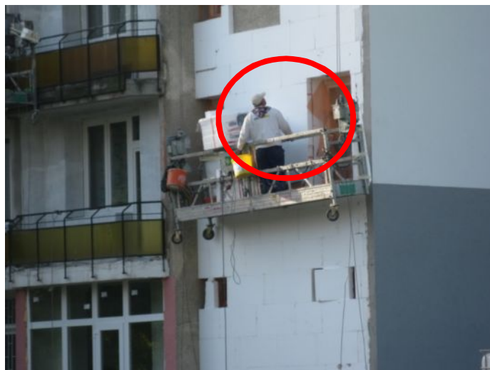
Munkavállaló egyedül a függesztett munkahídon
